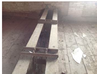
Estremità della trave alloggiata nella muratura perimetrale
