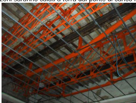
Travi in acciaio all'intradosso del solaio da rimuovere
