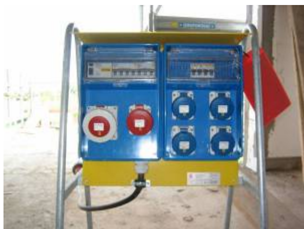
Foto 8.1 – quadro elettrico di distribuzione finale con targhetta recante la sigla ASC
