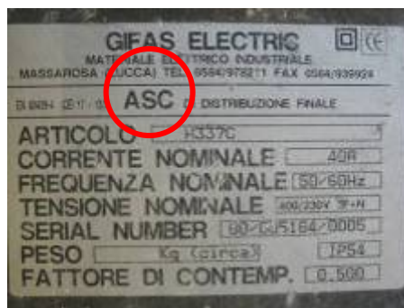
Foto 8.1 – quadro elettrico di distribuzione finale con targhetta recante la sigla ASC
